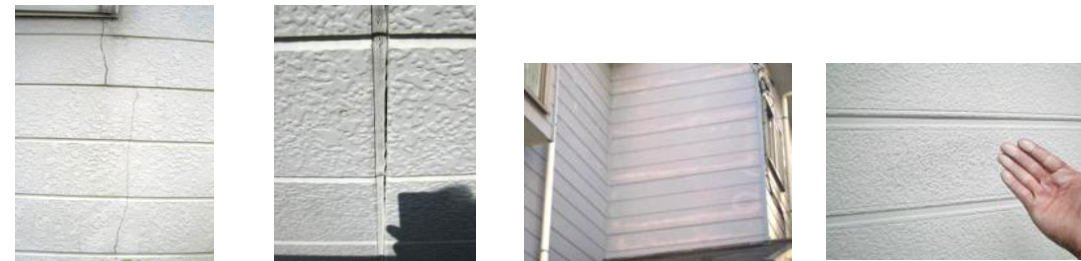
外壁にヒビが入っている 外壁目地のコーキングの劣化 外壁の色褪せ・汚れが目立ってきた 外壁から白い粉が吹いている
