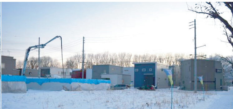
▲2期分譲は現在3棟が基礎工事中です。
